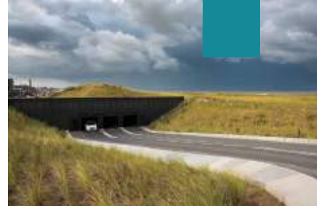
Garage verwerkt in een kustwering (Katwijk).
