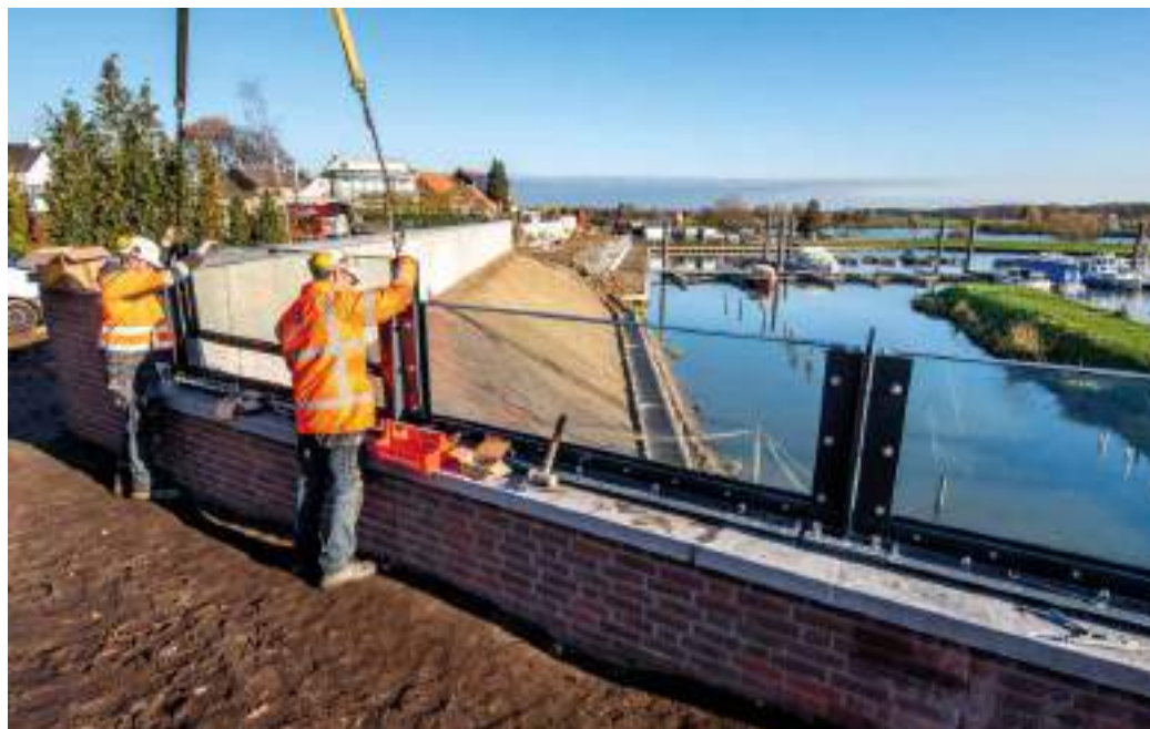
Het plaatsen van de glazen elementen (Neer).
