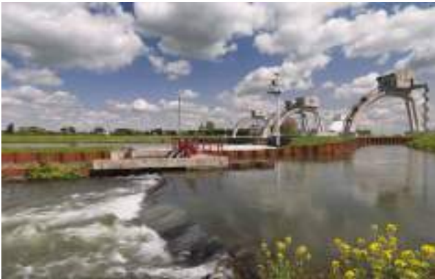
Vistrap bij het stuwencomplex bij Hagestein, waardoor de vissen omhoog kunnen zwemmen bij gesloten stuw.
