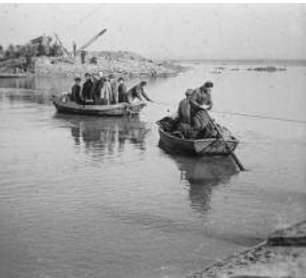
Burghsluis 1953. Dijkdoorbraak omdat het talud het begaf.
